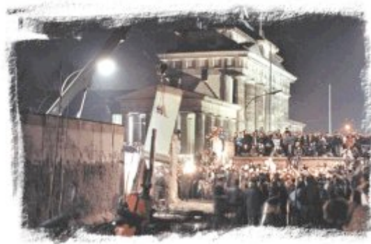
Demolición del muro de Berlín en la zona de la Puerta de Brandemburgo
