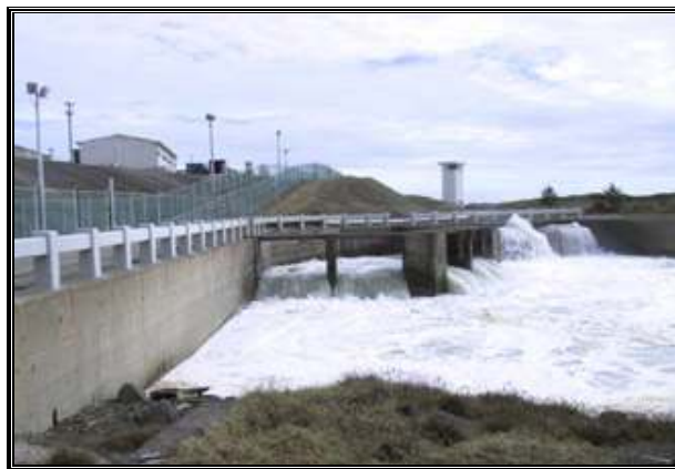
Descarga del agua de enfriamiento.
